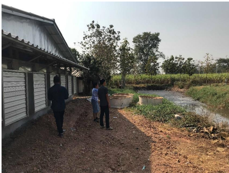
รูปที่ 1 แสดงลักษณะและสภาพของบ่อรับน้ำเสียแบบดั้งเดิม ซึ่งเป็นบ่อดิน 1 บ่อ ที่ไม่มีการคลุมบ่อ
