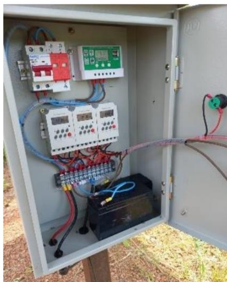
รูปที่ 4 วงจรควบคุมการทำงานที่ได้จากการออกแบบและทำการติดตั้งเพื่อควบคุมการรดน้ำ
